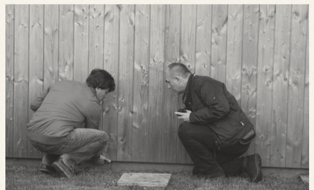
Begutachtung der Sockeldetails
