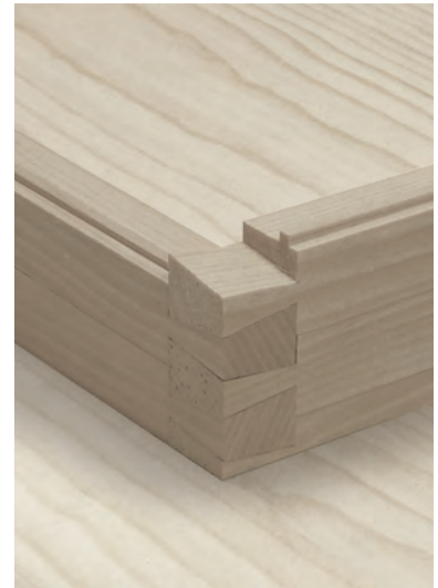
Abb.10: Konstruktionsmodell Fügung mittels „Tiroler Schloss“
