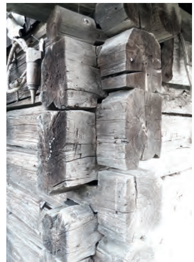
Abb.06 & 07: Holzständerbau bzw. Holzblockbauecke
