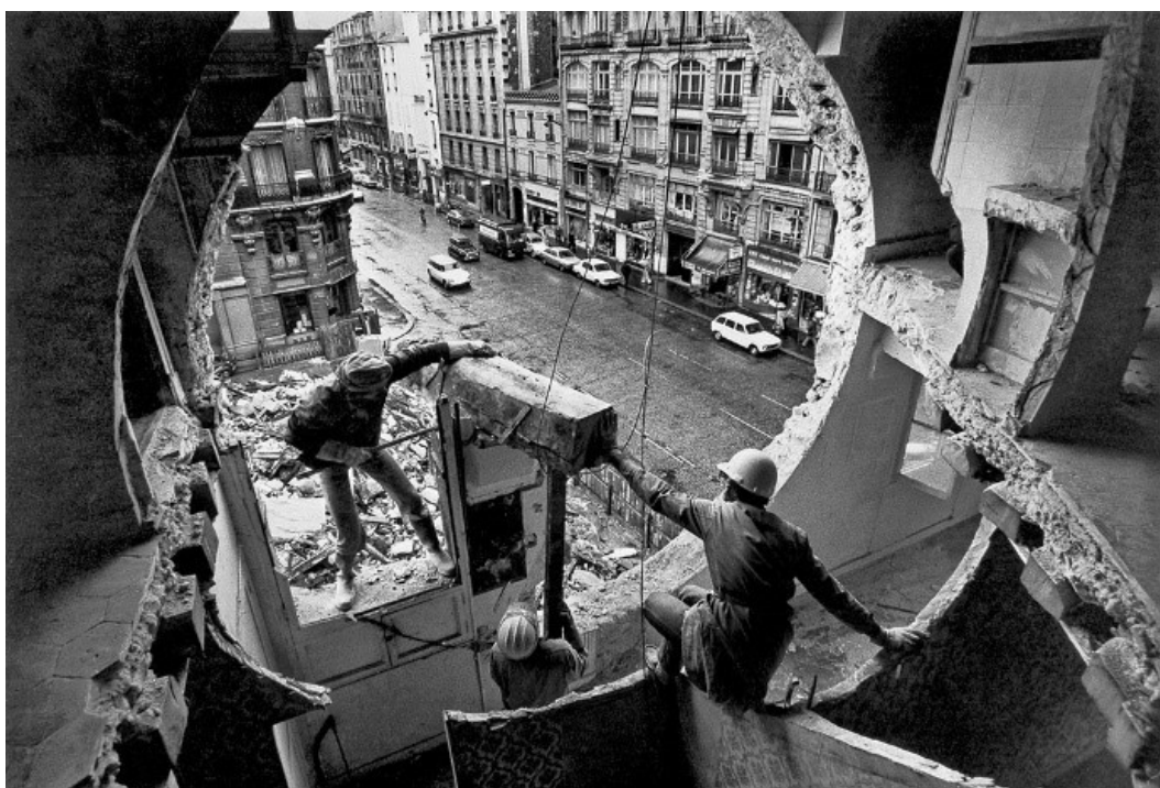
Abb. 28: Wandöffnungen: Freilegung des Schichtaufbaus à la Gordon Matta-Clark
