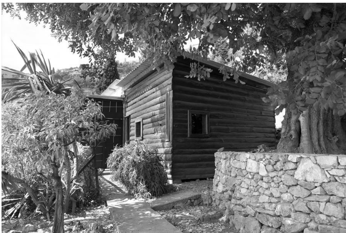
Abb. 17: Le Corbusier: Le Cabanon bei Roquebrune-Cap-Martin, Frankreich
