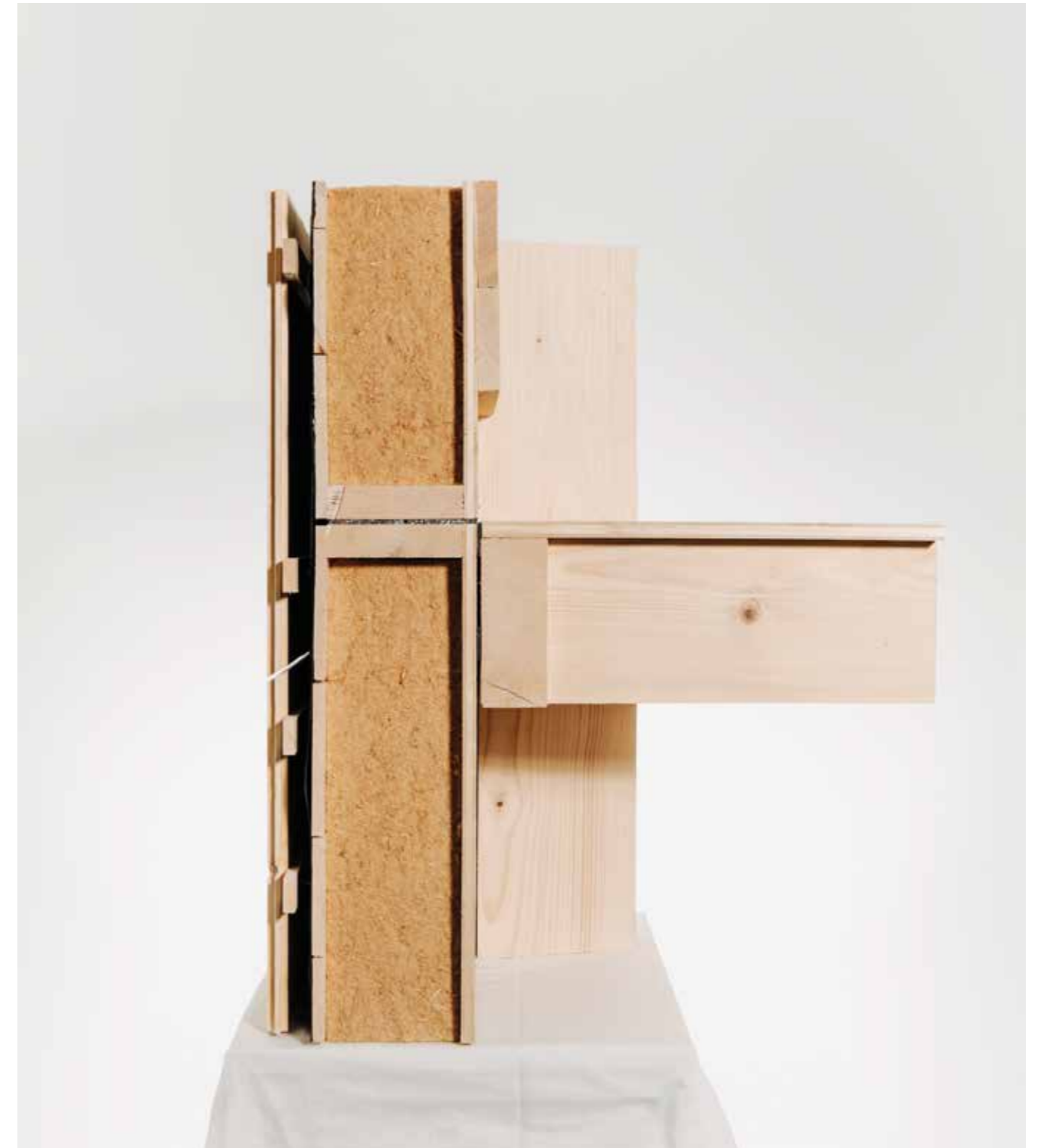
Mockup 1:2 Seitenprofil
