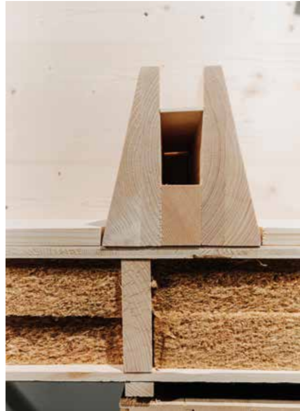
Mockup 1:2 Detail- Stütze
