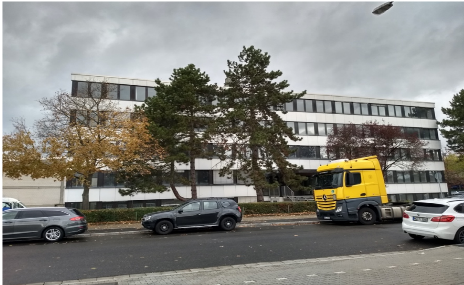
Abbildung 13 Foto Straßenansicht Ferdinand-Porsche-Str. 26
