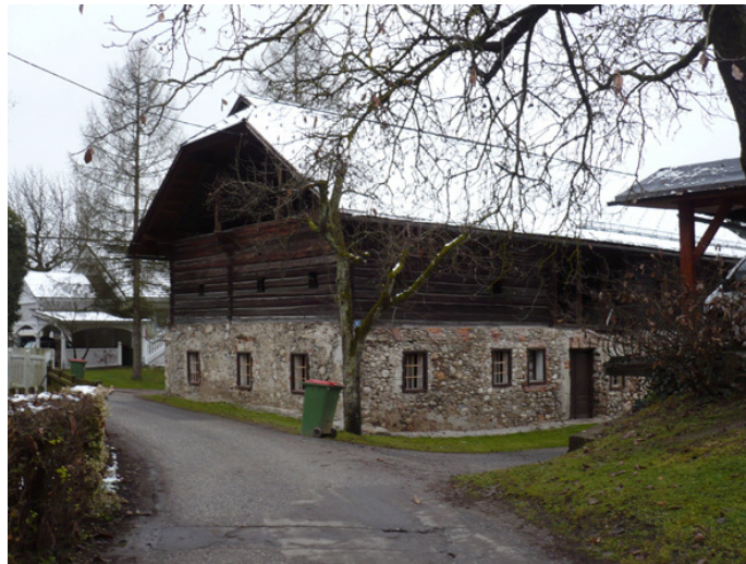
Blockbau auf Natursteingeschoss
