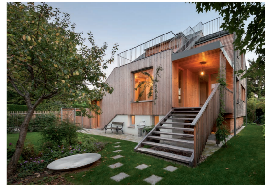
Sanierung Haus W., Wien
